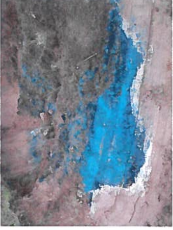
Zone 2 matières épurantes
